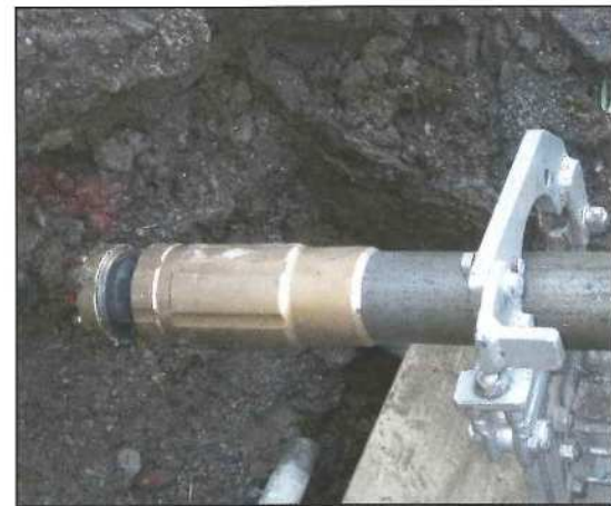
機械設置状況
