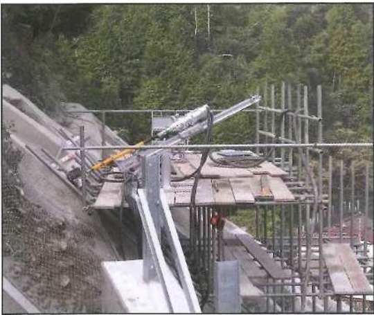
機械設置状況
