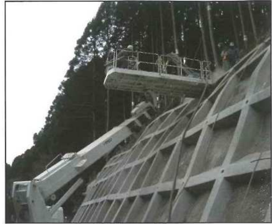
機械設置状況
